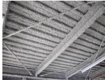
例：耐火被覆吹付け材（天井）
