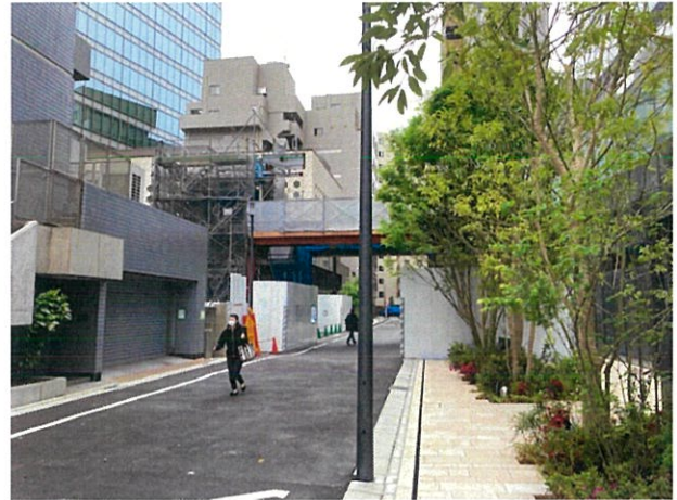
上空通路の工事状況（2021年4月17日現在）
