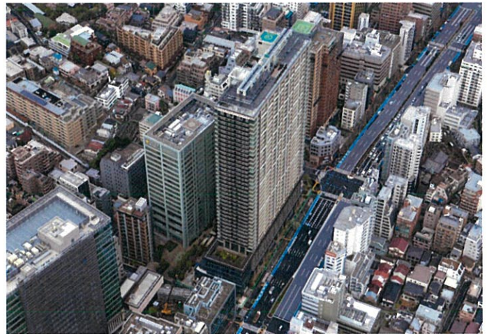
権利者への引渡しが行われた北街区（全景）
