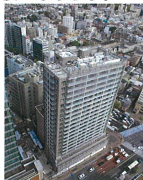
SB棟の状況
